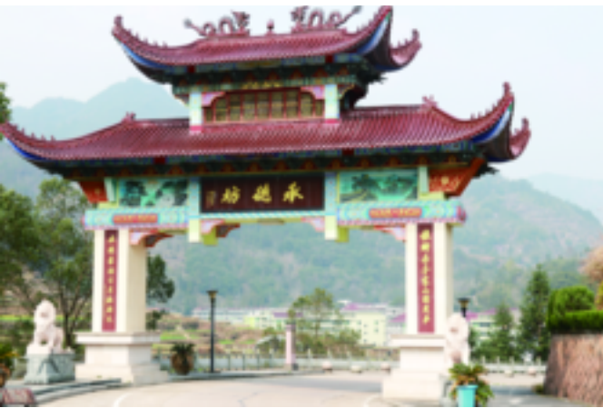
碧溪村主入口
